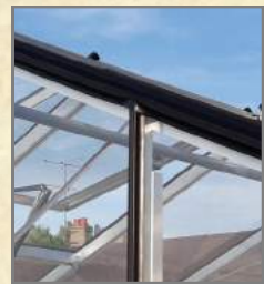
Fixation vitrage avec Joint EPDM
