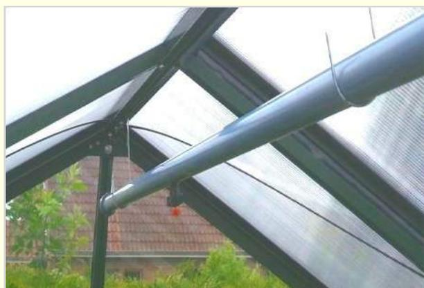
Tube en PVC rigide de diamètre 32 mm avec
